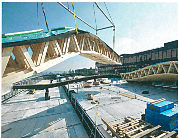
Montage des rund 80 x 28 m grossen Dachs des Arch_Tec_Labs. Die Konstruktion besteht aus 168 Bindern aus rund 50000 Holzplatten, die mit genagelten Anschlüssen statisch wirksam verbunden sind.
