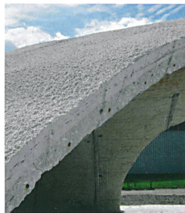
Die Betonplatte ist 5 cm dick. Darüber befindet sich eine Spritzbetonschicht.
