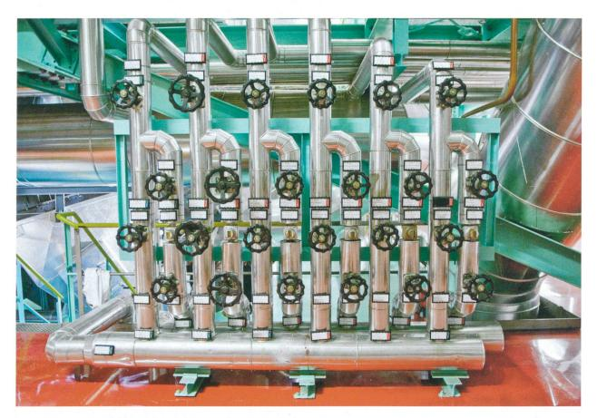
Kesselentwässerungsstation des Holzheizkraftwerks (HHKW) Aubrugg. Die Wärme-Kraft-Kopplungsanlage für Mittellastbetrieb wird im Winter als Ergänzung zum Kehrichtheizkraftwerk von ERZ Entsorgung+Recycling Zürich betrieben.
