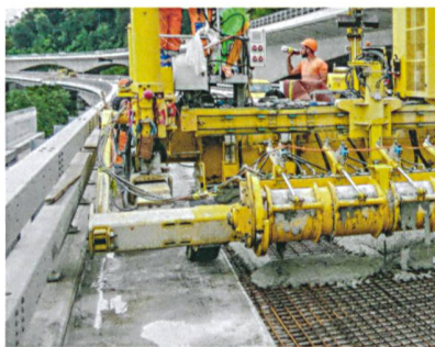
Einbau einer bewehrten, 50 mm dünnen UHFB-Schicht zur Verstärkung und Abdichtung.
