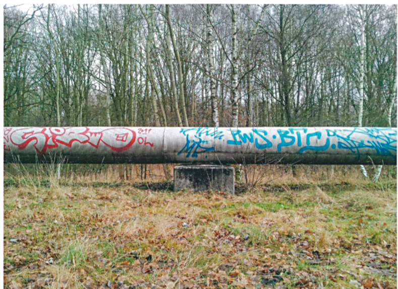
Überirdisch verlegte Fernwärmeleitung in Bremen.
