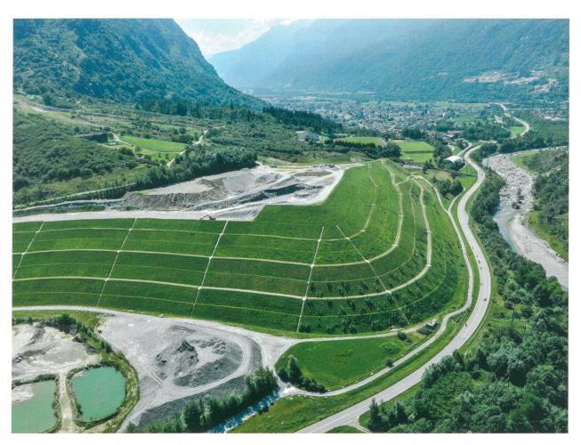
Materialdeponie «Buzza di Biasca»: Das Ausbruchmaterial der Tunnellose Bodio und Faido gelangte über eine Förderbandanlage vom Installationsplatz Bodio ins benachbarte Bleniotal. Dort wurde es in einem ehemaligen Bergsturzgebiet aufgeschichtet.
