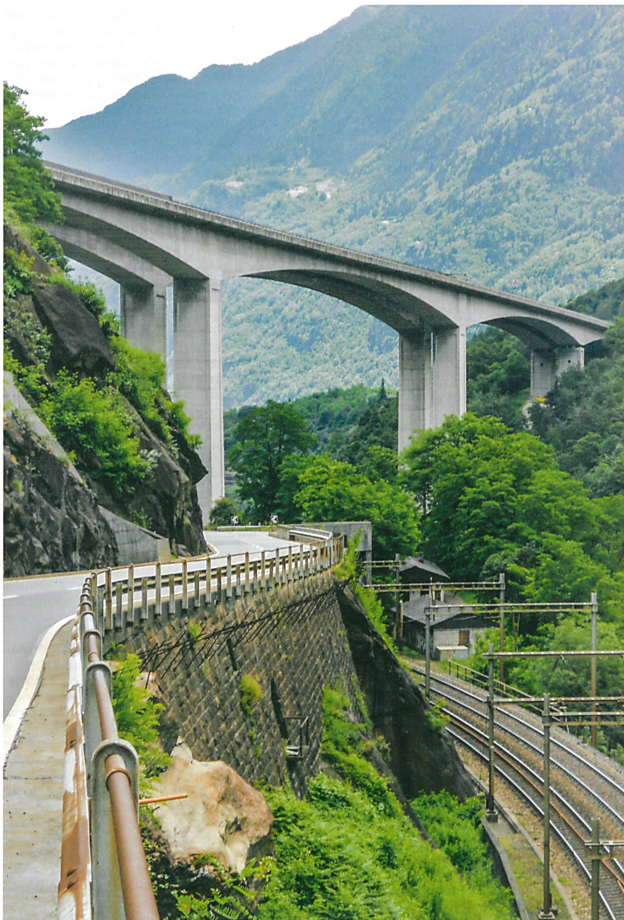
Verkehrslandschaft Leventina: Kantonsstrasse, Autobahn und Eisenbahn zwängen sich durch die Biaschina zwischen Lavorgo und Giornico. Der elegante Biaschina-Viadukt ist mit 110 m über Talgrund eines der höchsten Brückenbauwerke der Schweiz.
