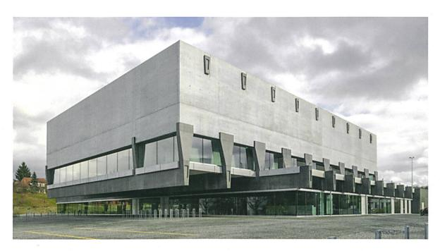
Sporthalle Weissenstein: Die statischen Elemente des Sichtbetonbaus wurden mit einer Lasur aus Grafit hervorgehoben.
