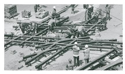
Etwa 1.4 km Gleise, 18 Weichen, 3 Schmieranlagen und 6 Kreuzungen, **total rund 200 t** Gleise und Gleisanlagen werden aktuell auf dem Bellevueplatz ersetzt.
