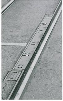
Gleisschmieranlagen: Die VBZ haben als Pionierbetrieb ab 2001 zusammen mit einem Hersteller ortsfeste Schienenbenetzungsanlagen eingebaut, getestet und weiterentwickelt. Kurz vor der Tramüberfahrt wird das Schmierfett in kleinsten Portionen durch kleine Öffnungen in den Schienen ausgepresst. Die weisse Masse wird von den Rädern verteilt, ist biologisch abbaubar, macht den Schienen-Rad-Kontakt nicht schlüpfrig – und verhindert das Quietschen der Trams in den Kurven.
