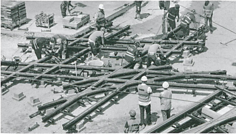
Etwa 1.4 km Gleise, 18 Weichen, 3 Schmieranlagen und 6 Kreuzungen, total rund 200 t Gleise und Gleisanlagen werden aktuell auf dem Bellevueplatz ersetzt.
