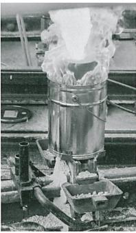
Thermit-Schweissungen: Anstatt die Schienen mit ausführungsmässig anspruchsvolleren elektrischen Schweissungen im Lichtbogenverfahren zu verbinden, geht das auch auf die preisgünstigere aluthermische Art. Bei komplexen Anlagen wie Weichen oder Kreuzungen greift man auf die elektrischen Schweissungen zurück.
