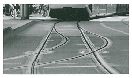
**Delfin:** Wenn die Hüllkurve, die das Tram beim Befahren einer Kurve beschreibt, mit den benachbarten Häusern in Konflikt geraten würde, muss das Tram eine ausholende Kurve fahren, also bei der Rechtskurve zuerst nach links ausholen. Bei einem Lkw – vor allem mit Anhänger – ist das selbstverständlich, beim Tram eher selten anzutreffen.
