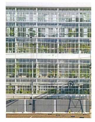
Die doppelschichtige, inwendig begrünte Fassade ist ein dünnhäutiger Puffer und entlastet die Gebäudehülle von weiteren bauphysikalischen Schutzmassnahmen.
