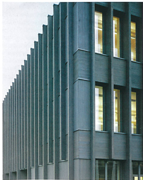
Rippenfassade des Erweiterungstrakts am Gymnasium Strandboden: Der Grundraster 2×2 m gilt für Gestaltung und Tragwerk (vgl. Grundriss oben: Stützen rot gekennzeichnet).
