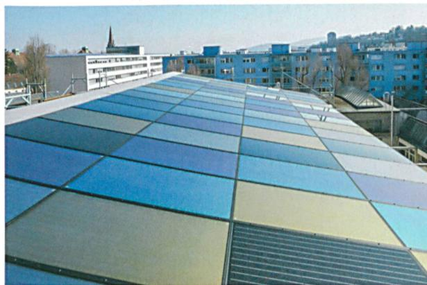
Oben: Kohlesilo am Gundeldingerfeld, Basel. Auf dem Dach wurden vier verschiedenfarbige PV-Module (grün, gold, blau und grau) sowie zum Vergleich schwarze Standardmodule eingesetzt. Dadurch kann der Abminderungsfaktor der verschiedenen Farben im direkten Vergleich zu Standardmodulen ermittelt werden.
