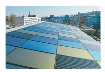
Oben: Kohlesilo am Gundeldingerfeld, Basel. Auf dem Dach wurden vier verschiedenfarbige PV-Module (grün, gold, blau und grau) sowie zum Vergleich schwarze Standardmodule eingesetzt. Dadurch kann der Abminderungsfaktor der verschiedenen Farben im direkten Vergleich zu Standardmodulen ermittelt werden.
