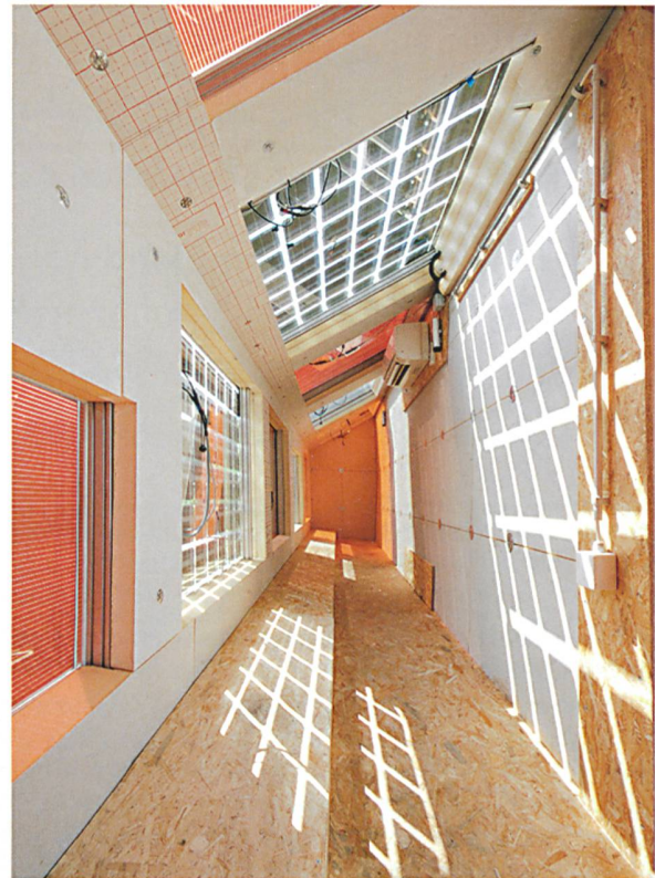
Der Prüfstand an der Supsi ist als Niedrigenergiehaus ausgeführt. Hier werden 22 verschiedene Module auf ihre Eignung als Baukomponenten geprüft.
