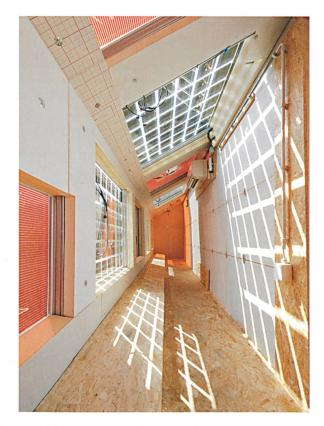
Der Prüfstand an der Supsi ist als Niedrigenergiehaus ausgeführt. Hier werden 22 verschiedene Module auf ihre Eignung als Baukomponenten geprüft.
