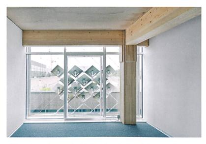
Blick aus einem Büro: **adaptive Solarpaneele** an der Fassade des House of Natural Resources.
