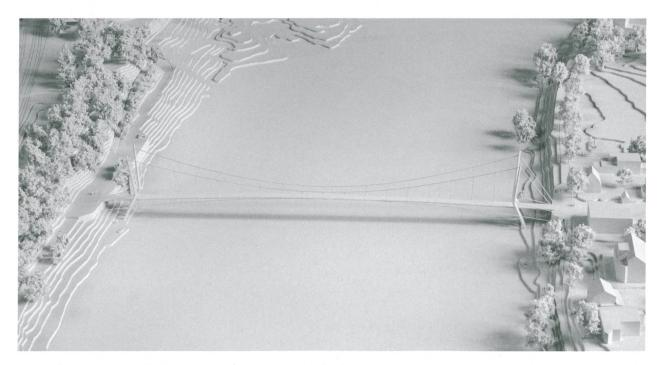
Bei der Hängebrücke vom Ingenieurbüro Miebach werden beide Ufer gleichwertig behandelt und das Flussbett nicht tangiert.
