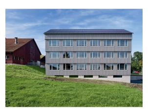
Ins Ensemble eingefügt: das neue Fachstellenhaus des BBZ auf dem Arenenberg, das Ende Oktober 2014 bezogen wurde. Die bauliche Konzentration wird gestärkt, die Wiese bleibt frei. Die lasierte Fassade aus Fichtenholz ist gegen unten abgetreppt und bietet einen guten konstruktiven Schutz.
