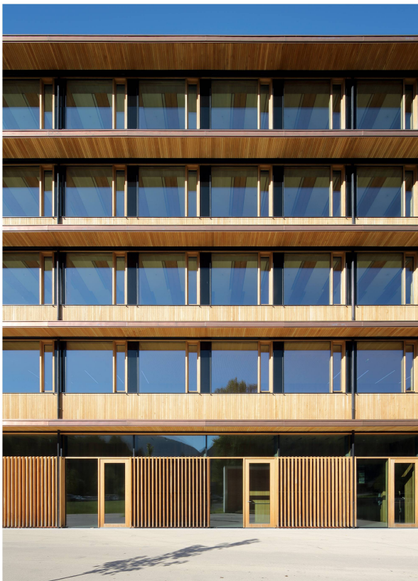
Auch die Fassade nimmt den Rhythmus der Konstruktion auf und zeigt eine strenge Gliederung, die die Länge betont. Dank sorgfältigen Details erscheint das Bürogebäude edel.
