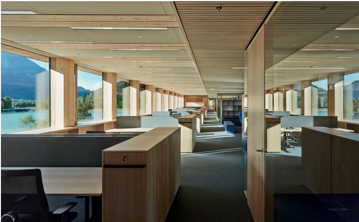
Aus dem Modul des Bausystems heraus entwickelt: Die Büroräume für die 270 Angestellten der Illwerke in Vandans bieten Aussicht in die Bergwelt des Montafons. Im Innern ist das Holz der Tragkonstruktion ohne Verkleidung zu sehen.
