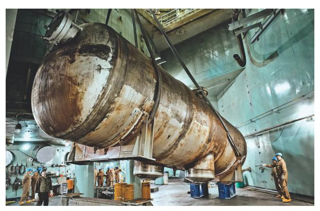
KKW Lubmin bei Greifswald: Dampferzeuger und Reaktordruckgefässe sind an Trocken- und Nasszerlegeplätze gebracht worden.
