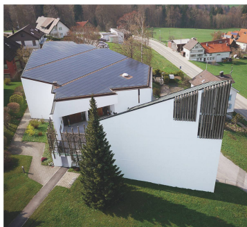
Aussensanierung der 1963 erbauten Kirche in Heiden: Das polygonale Dach ist vollflächig mit rahmenlosen monokristallinen Modulen eingedeckt. Dank Randabschluss mit Blindelementen aus dunklem Glas entsteht ein homogener Gesamteindruck.
