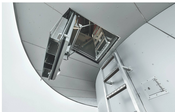
Der beidseitig bedienbare Notausstieg funktioniert hydraulisch.
