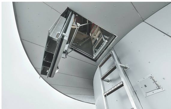
Der beidseitig bedienbare Notausstieg funktioniert hydraulisch.
