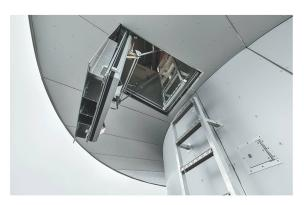
Der beidseitig bedienbare Notausstieg funktioniert hydraulisch.
