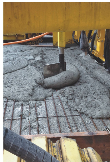
Mittels einer Verteilschnecke der Einbaumaschine wurde der Frisch-UHFB je nach Etappe auf 120 bis 600 cm Breite versetzt (oben links). Eine Art Schaber verteilt den Frisch-UHFB , der mit leistungsstarken Vibratoren fertig eingebaut wird (oben rechts).
