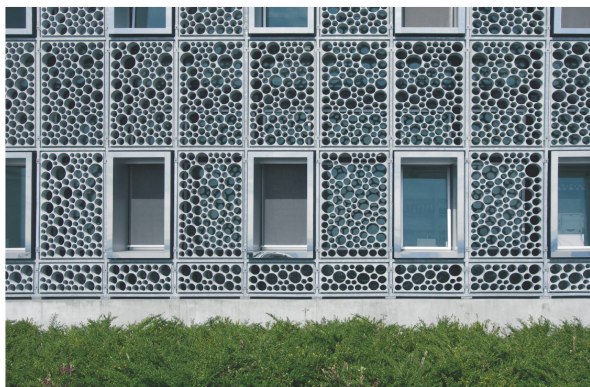
UHFB-Fassadenelemente für das Swatch-Gebäude in Cormondrèche NE.
