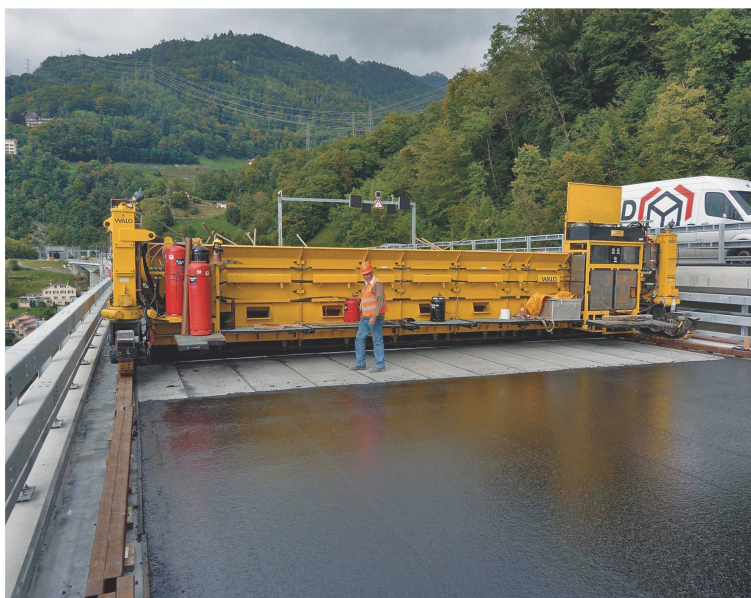
Abdichtung der UHFB-Schicht, die das Chillon-Viadukt verstärkt.
