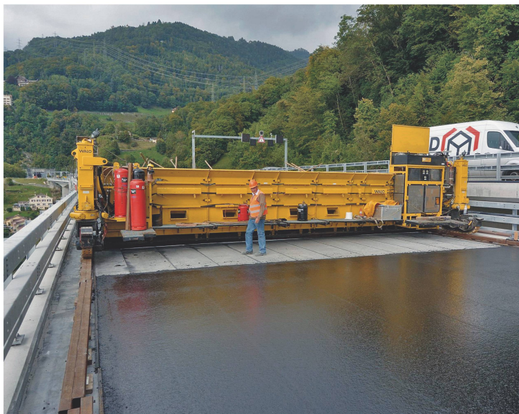
Abdichtung der UHFB-Schicht, die das Chillon-Viadukt verstärkt.
