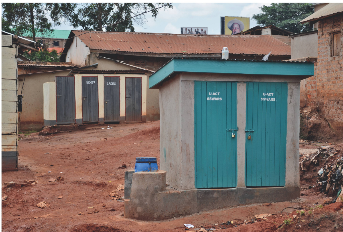
Über 1500 Menschen profitieren von den 160 ventilerten U-ACT-Toiletten, die in Kampala gebaut wurden.
