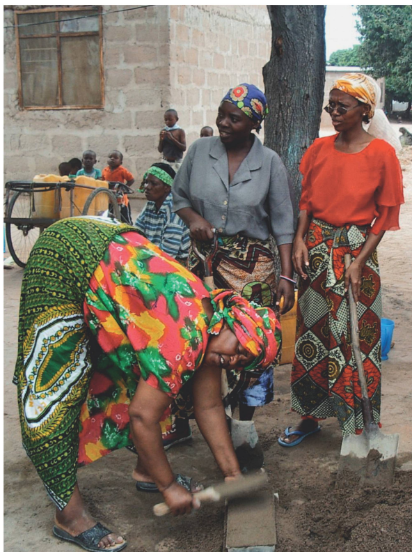
Frauen helfen bei der Anfertigung der Bausteine für die Toilettenhäuschen für den Stadtteil Chang'ombe in Tansania.
