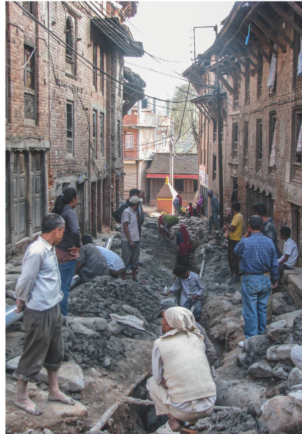
Bewohner der Stadt verlegen die simplifizierte Kanalisation, die zur dezentralen Kläranlage führt. Sie hat einen geringeren Rohrdurchmesser und transportiert nur Haushaltsabwässer und kein Meteorwasser.
