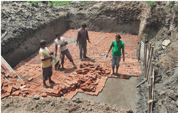
Der Boden der dezentralen Kläranlage besteht aus lokal hergestellten Backsteinen und wird danach mit Zement verputzt.
