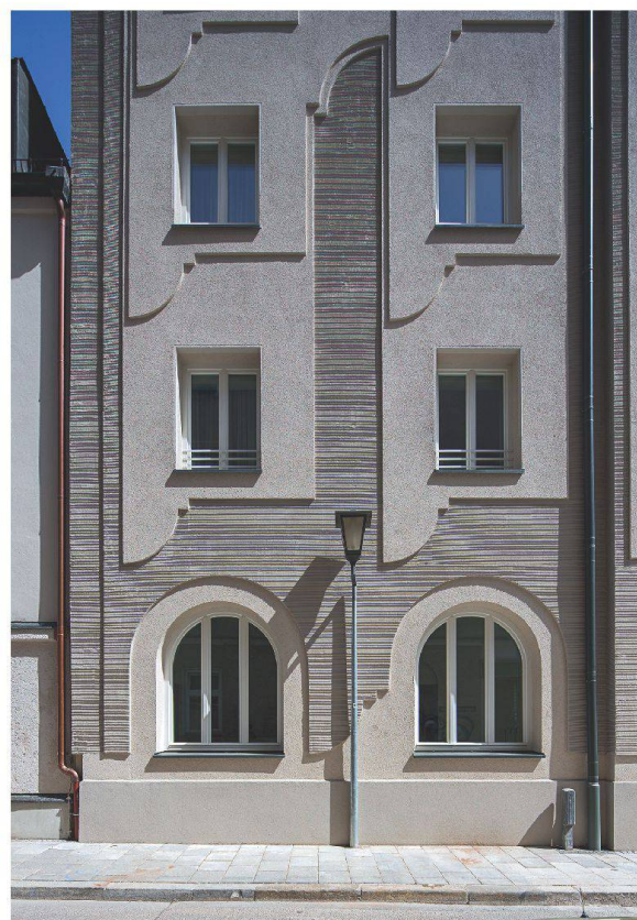
Bürogebäude Ismaninger Strasse, München, 2013: Das ornamentale Relief verleiht der Fassade Tiefe, denn überdeutlich wird ein Schichtaufbau formuliert. Der glatte Silikonharz-Dekorputz wird von einer horizontal gerillten Kratzputzstruktur kontrastiert. Die Fassade ist durch die Komposition einfacher geometrischer Formen reich an Gestaltung. Sie scheint dem Gebäude ein massgeschneiderter Anzug aus feinem Stoff zu sein.
