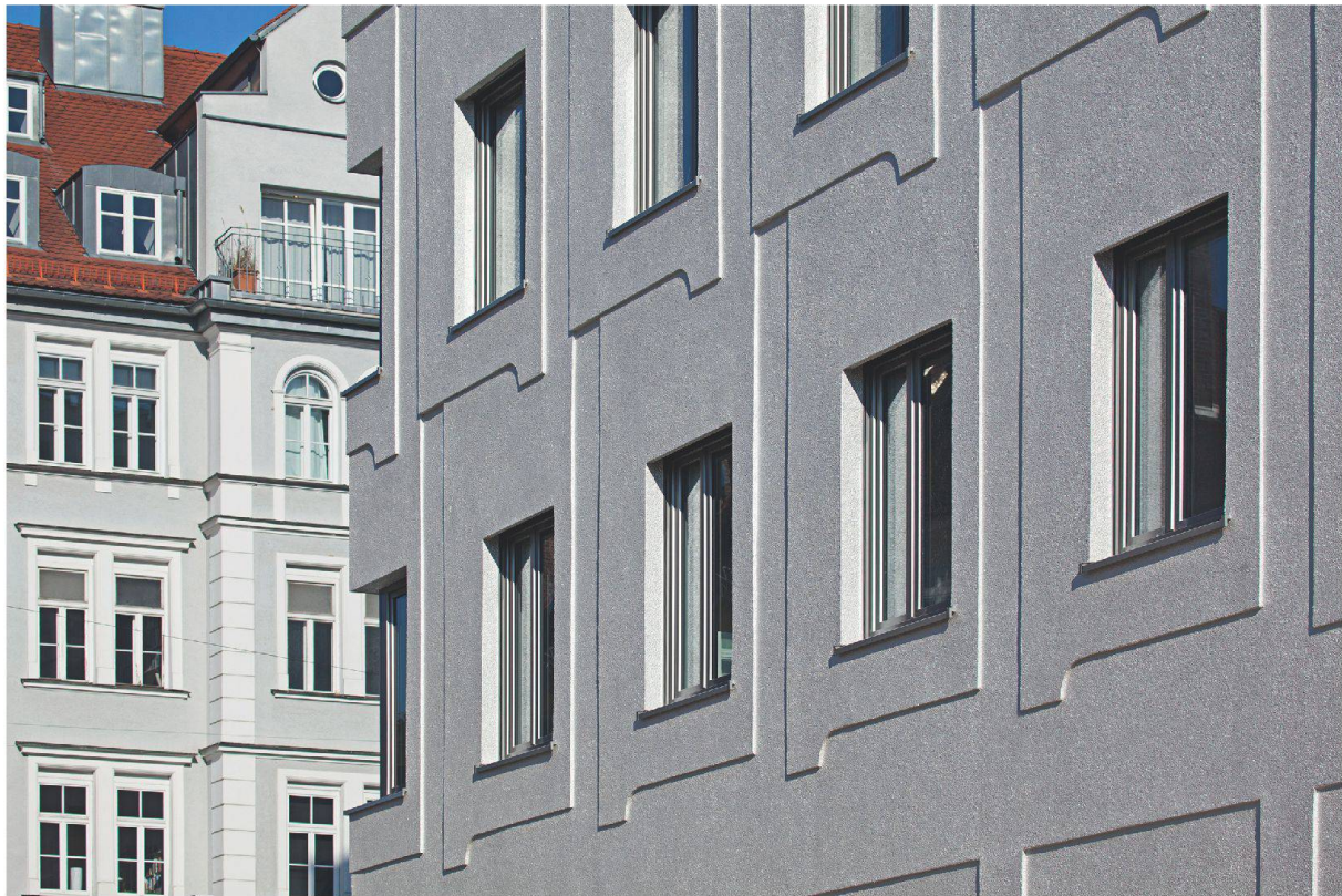
Büro- und Geschäftsgebäude Welfenstrasse, München, 2013: Das Relief der VAWD besteht aus Formelementen, deren Anordnung der regelmässigen Fensterstruktur folgt. Sie überlappen einander schuppenartig, sodass die Fassade nach oben hin um einige Zentimeter auskragt. Das Fassadenbild ist trotz seiner Flächigkeit reich gegliedert und gut proportioniert. Der warme Silberton des Silikonharz-Oberputzes veredelt die Fassade; sie wirkt elegant und wertig. Die dem Entwurf zugrunde liegenden Gesetzmässigkeiten sind ablesbar. Durch die strenge Ausrichtung des Ornaments an den Fenstern scheint es nicht beliebig, sondern strukturell zu sein. Unterstützt wird dieser Eindruck durch die Versprünge, mit denen die Blechabdeckung der Dachkante dem Relief folgt.
