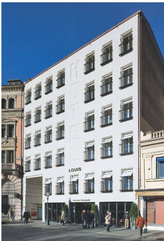
Hotel Louis am Viktualienmarkt, München, 2009: Mittels vorgefertigter, verklebter Fassadenprofile aus einem sehr leichten Glasschrotmaterial werden die fehlenden klassischen Elemente zur Konstruktion und Artikulation einer Öffnung thematisiert. Sie erinnern auf den ersten Blick an gewohnte Bilder, grenzen sich durch ihre Anordnung aber auch von ihnen ab. Das Wort «Hotel» ist in grossen Buchstaben in die VAWD eingepreßt.
