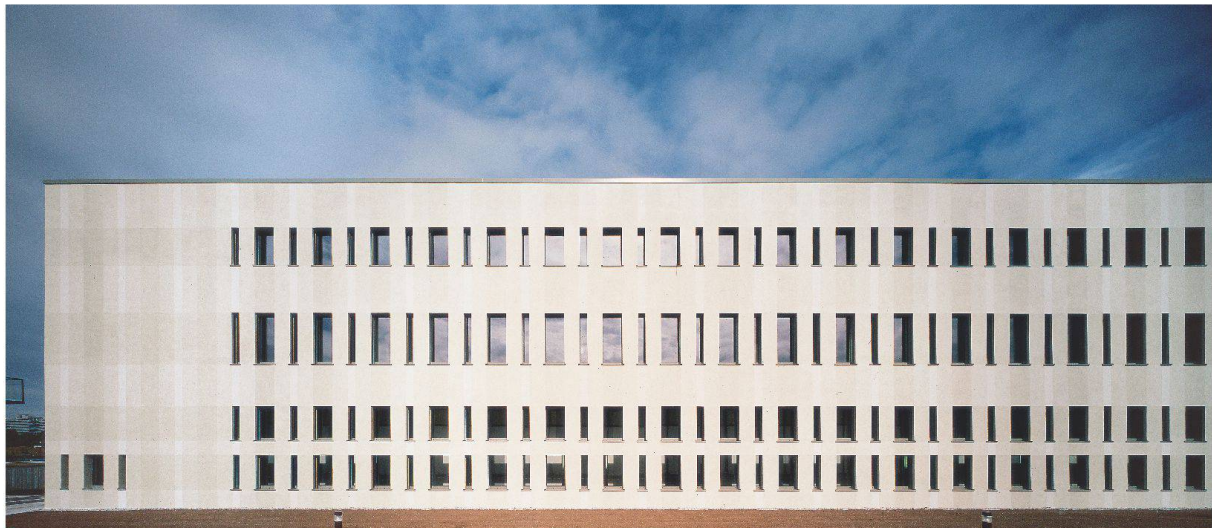
Bayerisches Forschungs- und Technologiezentrum für Sportwissenschaft, München, 2004: Hier wollten die Architekten ausloten, wie sich optisch der Eindruck einer Fassade erwecken lässt, die sich wie ein dünnes Trikot über das Gebäude legt. Die Fragilität der VAWD wird so ästhetisch überhöht. Ein dünner, feinkörniger (1 mm Korngrösse) mineralischer Leichtputz ist mehrfach farblasiert. Die horizontalen und vertikalen Streifen ergeben ein textiles Muster, durch die unterschiedlichen Farbnuancen auch mit einer gewissen Tiefe. Die Fensteröffnungen wirken wie aus diesem Muster herausgeschnitten.
