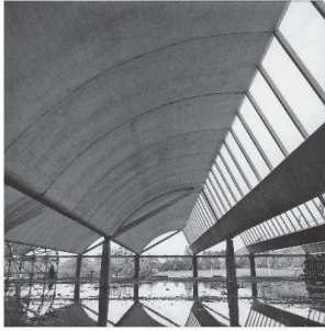
Das Sheddach des Verbands Schweizerischer Konsumvereine (VSK, heute Coop) wurde 1961 nach dem Entwurf des Ingenieurs Heinz Hossdorf erstellt. Es besteht aus Fertigteilen, die in Längsrichtung hintereinander versetzt und vorgespannt wurden. Die Konstruktion wurde damals anhand eines physischen Modells im Massstab 1:10 statisch nachgewiesen. Heute würde man dieselbe Aufgabe mit einem virtuellen Finite-Elemente-Modell (FEM) am Computer lösen.
