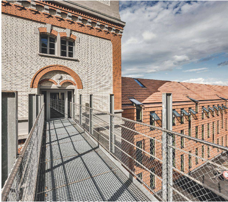
Gurtenareal in Bern: Blick auf das ehemalige Sudhaus in der Mittelzeile des Ensembles, rechts ein angefügter Neubau.
