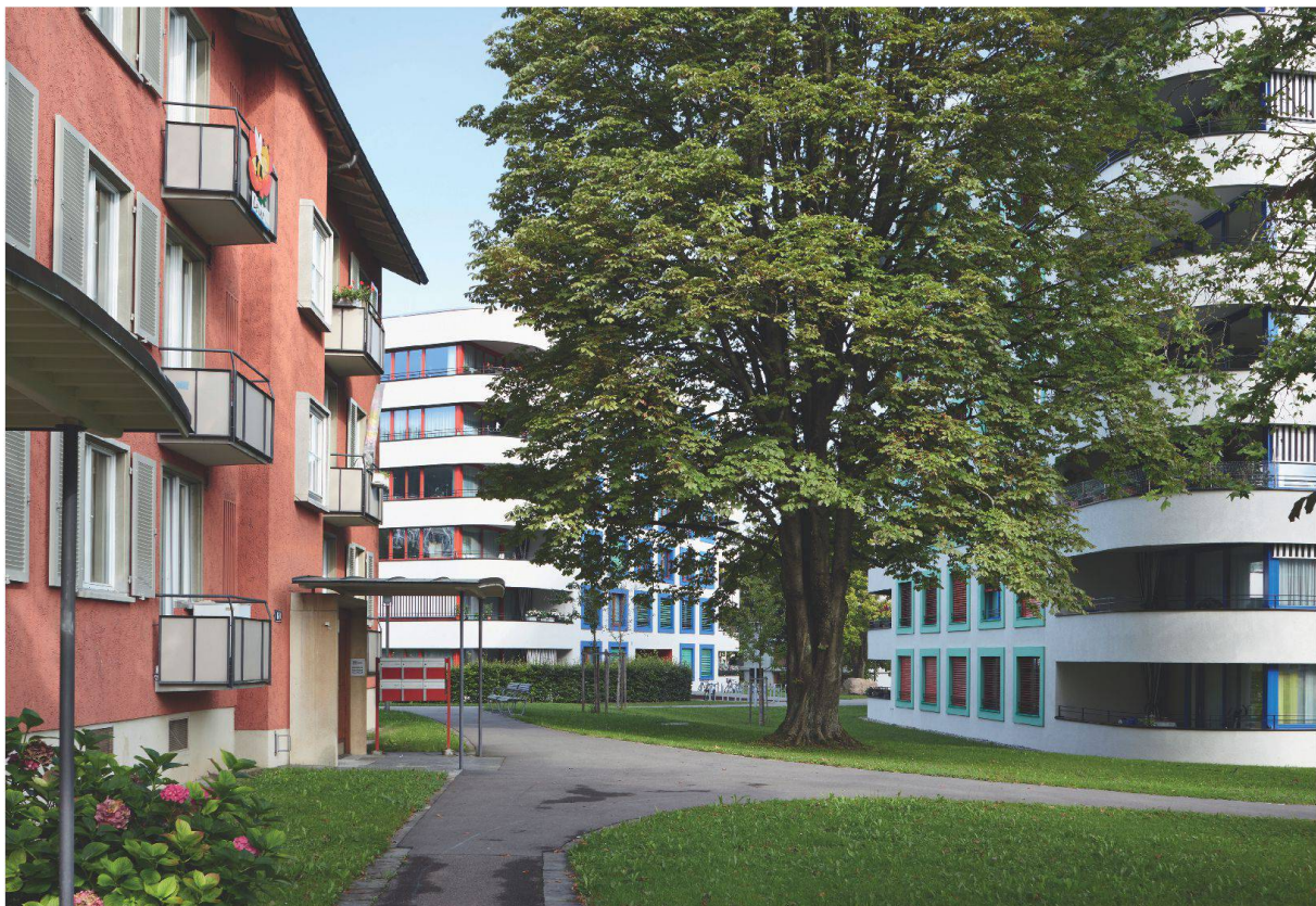
Ersatzneubauten aus der gegenwärtigen Verdichtungskampagne. Unend Architekten: Siedlung Rautstrasse (2014), Zürich Altstetten (oben), Burkhalter & Sumi Architekten: Siedlung Sonnige Hof (2012), Zürich Albisrieden (unten).
