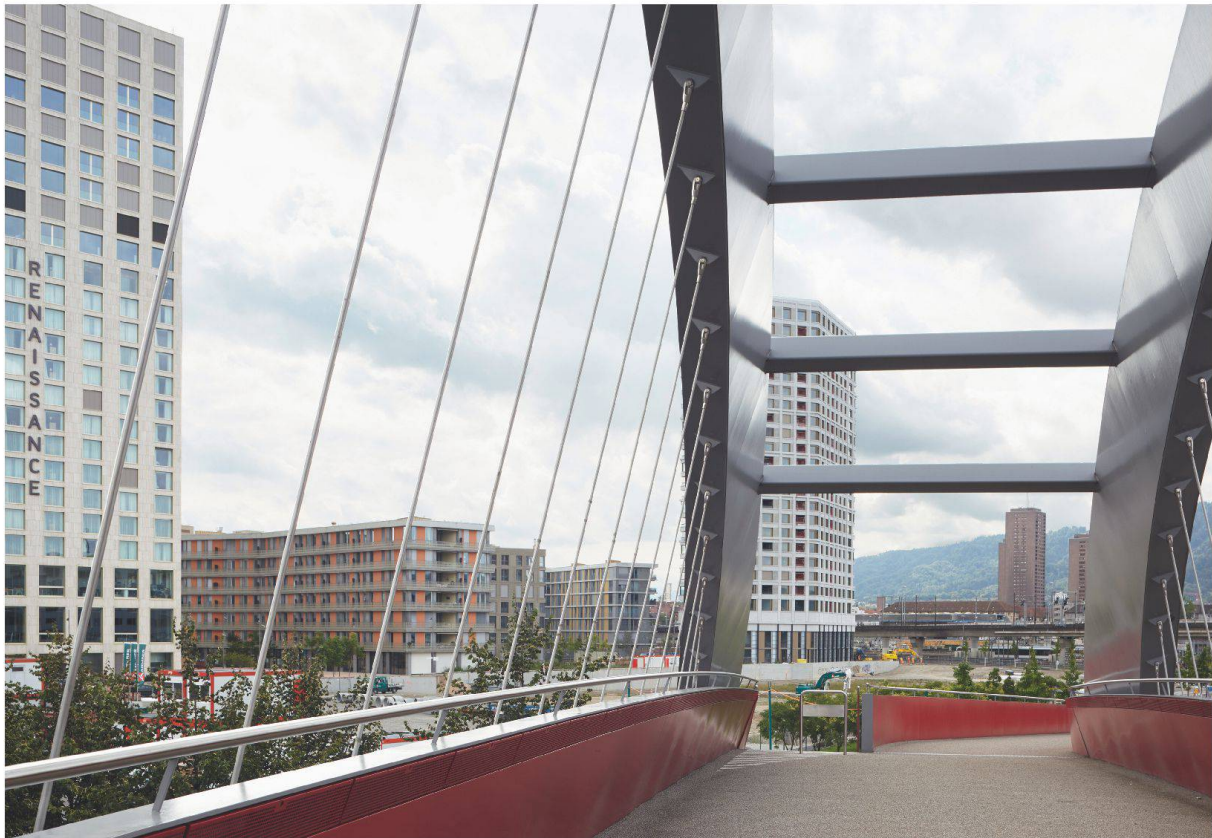
Der Gleisbogen erstreckt sich als rotes Band entlang des ehemaligen Industriegleises durch Zürich-West und erschliesst dem Langsamverkehr den Weg über die Pfingstweidstrasse zum Bahnhof Hardbrücke. Bauten von links nach rechts: Mobimo Tower, Wohnhäuser Am Pfingstweidpark und Wohnhochhaus Zölly. Rechts im Hintergrund die städtischen Hardau-Hochhäuser.
