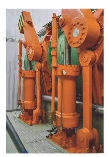
Durch die Schliessung der mächtigen Drosselklappe lässt sich die Betriebswasserleitung zu den Turbinen vom Seewasser absperren. Aus Sicherheitsgründen sind zwei Drosselklappen hintereinander eingebaut.
