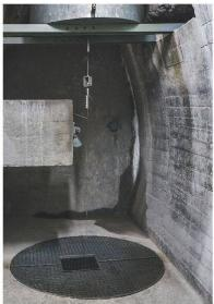
Die Staumauer ist durchzogen von Kontrollgängen und Pendelschächten. In jedem Schacht ist ein Lot aufgehängt, das die Bewegungen der Staumauer misst. Die Bewegung der Mauerkrone zwischen vollem und leerem See beträgt über 4 cm.
