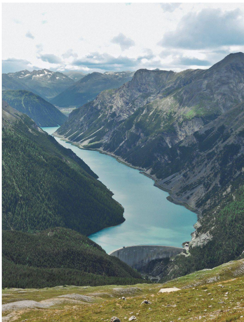
Blick vom Munt la Schera nach Livigno: Die 130 m hohe doppelt gekrümmte Bogenstaumauer (Kronenlänge: 540 m) liegt genau auf der schweizerisch-italienischen Grenze. Unterhalb der Staumauer beginnt das Gebiet des Schweizerischen Nationalparks, durch den der Spöl fliesst.
