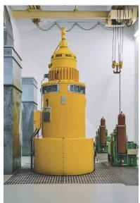
Bevor das Restwasser in den Spöl gelangt, wird es durch zwei kleinere **Dotierturbinen** am Fuss der Staumauer geleitet, um zusätzlichen Strom zu gewinnen.
