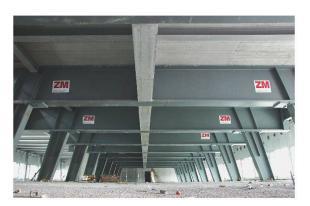
**Abfangtisch:** Das Raster von 5×12.5 m im bestehenden Trockenwerk ist für den Wohnungsbau, der oben aufgestockt wurde, nicht optimal. Ein Zwischengeschoss mit einem Trägerrost aus Stahl bildet den Wechsel (vgl. Schnitt oben).
