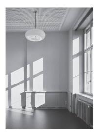
Das Innere des Zürcher Schulhauses Ilgen nach der energetischen Sanierung. Um den Minergiestandard zu erzielen, entschieden sich die beauftragten Architekten und Gebäudetechniker für eine 10 cm starke mineralische Innendämmung. Das Beispiel stammt aus dem Buch «Erneuerung von Innen».
