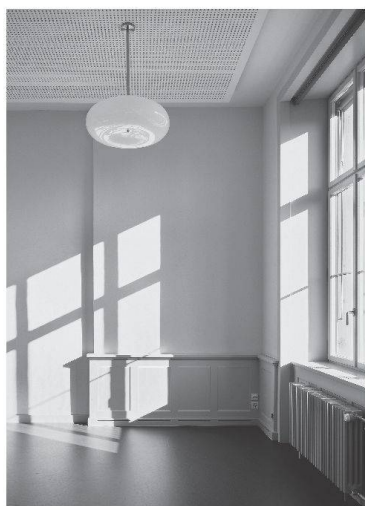
Das Innere des Zürcher Schulhauses Ilgen nach der energetischen Sanierung. Um den Minergiestandard zu erzielen, entschieden sich die beauftragten Architekten und Gebäudetechniker für eine 10 cm starke mineralische Innendämmung. Das Beispiel stammt aus dem Buch «Erneuerung von Innen».
