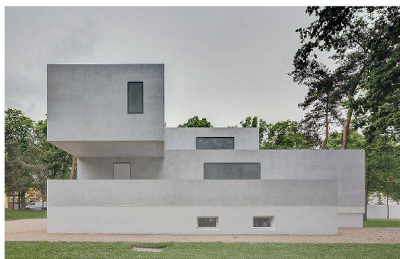
Der Neubau des Direktorenhauses Gropius: Auf der Gartenseite kragt das Obergeschoss frei aus.
