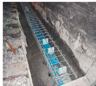
Einbau eines rostfreien Korbs aus Bewehrungsstahl vor der Füllung mit Schotter.
