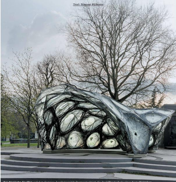
Der bionische Pavillon auf dem Campus der Universität Stuttgart zitiert die Deckflügelschale eines Kartoffelkäfers. Er wurde vor Ort aus 36 verschiedenen Elementen zusammengesetzt, die zuvor im Werk mit Industrierobotern gewickelt wurden ionik spielt in vielen Bereichen wie
