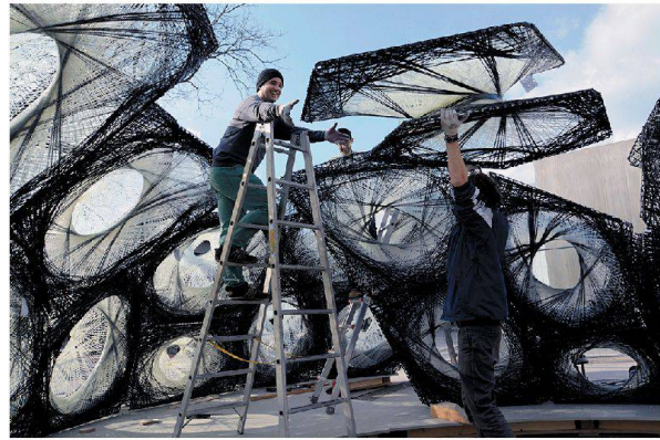
Spielend leichte Montage: Mit einem maximalen Gewicht von 24.1 kg lassen sich die Elemente von einer Person tragen.
