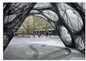
Oben: Rasterelektronenmikroskopie der Deckflügelschale eines Kartoffelkäfers (Leptinotarsa decemlineata). Die Dicke der Deckschicht variiert je nach aufzunehmender Belastung. Mitte: Der ICD/ITKE-Forschungspavillon 2012 war vom Aussenskelett des Hummers inspiriert. Harzgetränkte Glasund Kohlefasern kamen zum Einsatz. Darunter: Der Forschungspavillon 2014 wurde zusätzlich noch aus 36 verschiedenen Elementen zusammengefügt.
