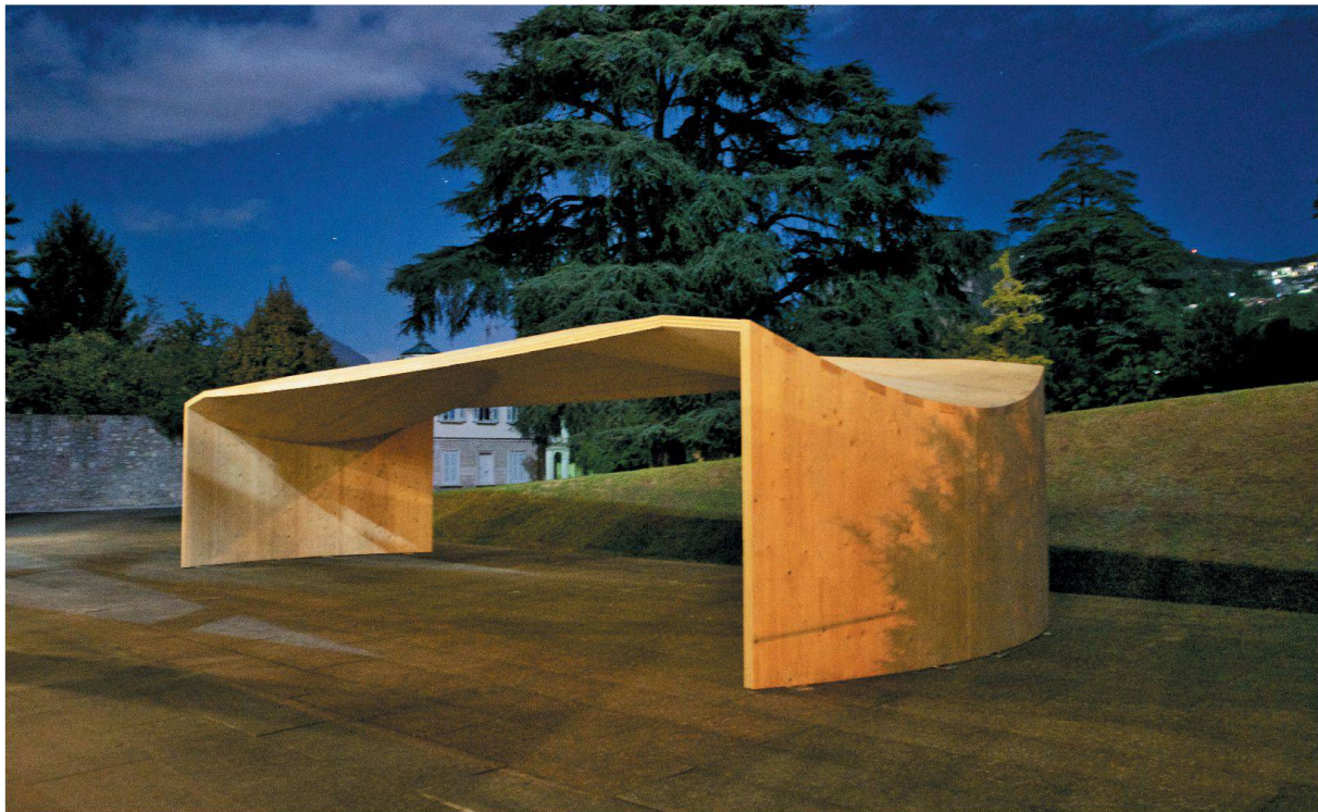
Der Holzpavillon auf dem Gelände der Accademia di Architettura in Mendrisio ist ein Faltwerk aus gekrümmten Holzscheiben.
