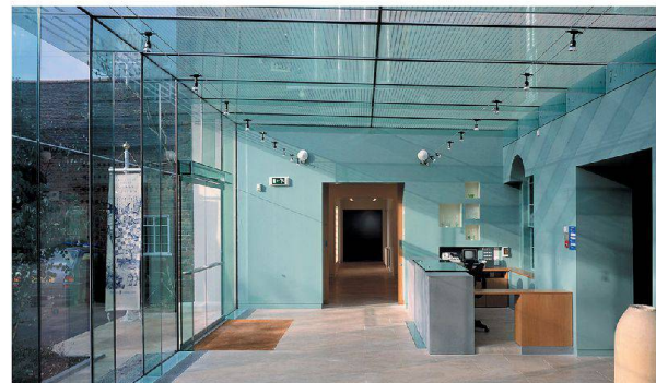
Glas pavillon der Ingenieure Dewhurst MacFarlane and Partners am Broadfield House in Kingswindford (GB, 1994) Er gilt bis heute als grösstes Glastragwerk, dessen Verbindungen nicht mit Profile und Schrauben ausgebildet wurden, sondern mit transparentem Giesshar. 2 Die Eckverbindungen der 3.5 m hohen Pfosten und der 5.7 m langen Riegel sind als Schlitz- und Zapfenverbindung dreilagiger Verbundglasträger ausgebildet. Der Pavillon dient als Erweiterung des Museums für Glaskunst. Architekt: Design Antenna, Richmond.
