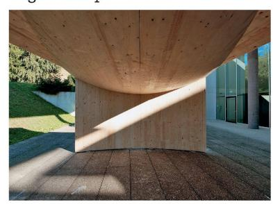
Der gekrümmte Pavillon aus Holz in Mendrisio trägt ohne Metallverbindungen.
