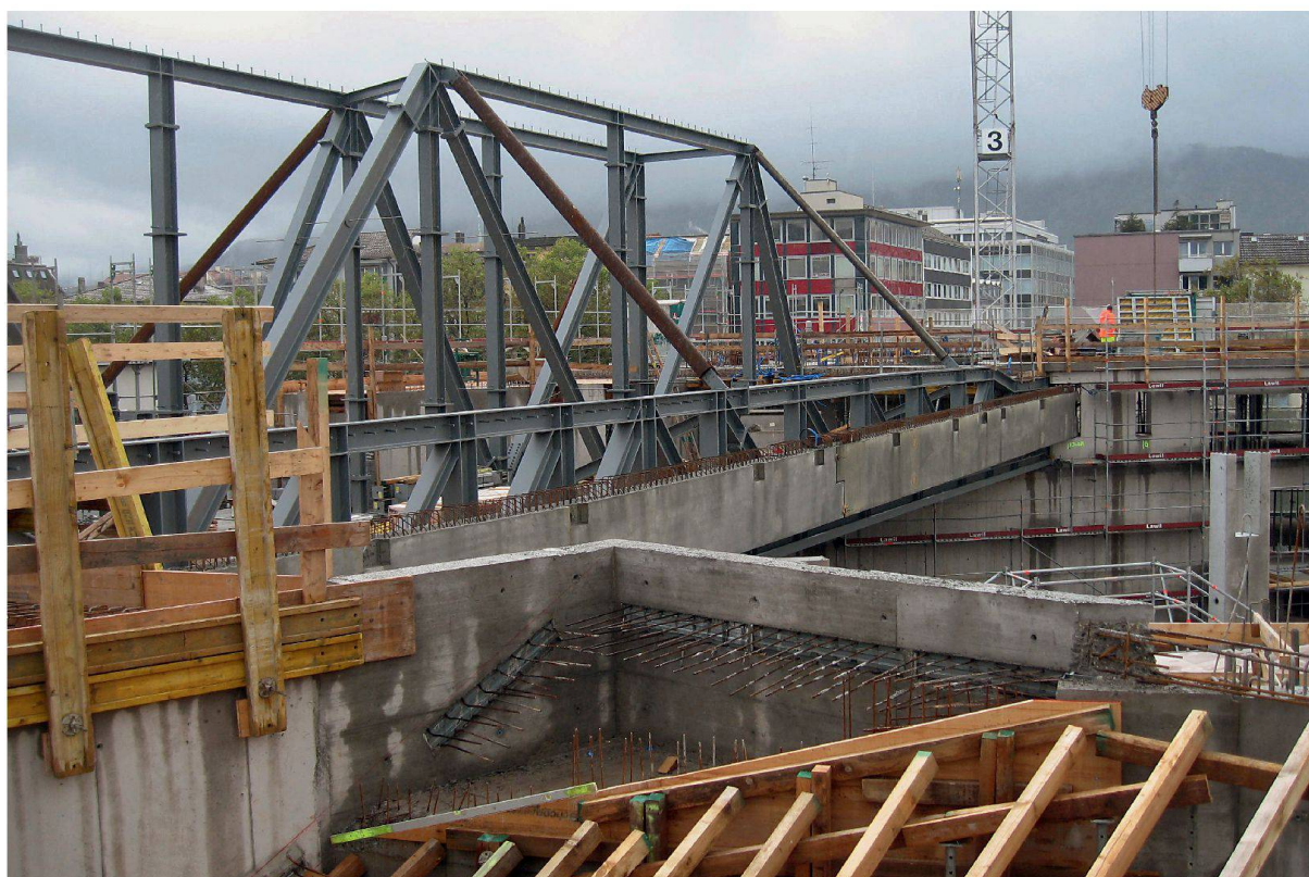
Baustelleneindruck: Links die ein- und dreigeschossigen Fachwerkträger der «Wohnbrücke» über der Tramhallenausfahrt. Parallel dazu der erste vorfabrizierte Betonhauptträger des Tramhallendachs mit den Aussparungen für die Sekundärträger. Rechts die Mittelstütze des folgenden Hauptträgers. Im Vordergrund die Schalung für die faltwerkartige Freitreppe zum Innenhof.
