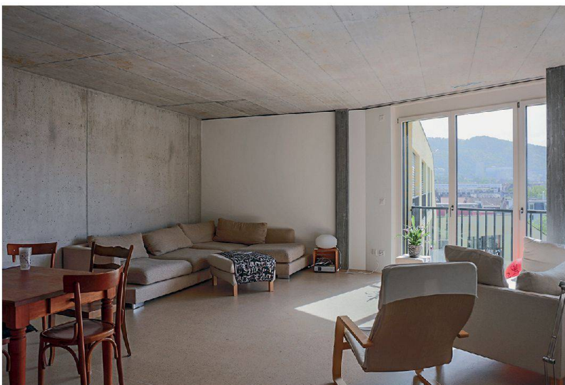
Skelettbauweise mit Sichtbetondecken: Blick in eine Wohnung.
