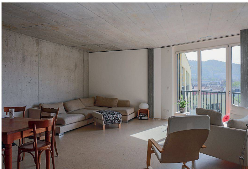
Skelettbauweise mit Sichtbetondecken: Blick in eine Wohnung.
