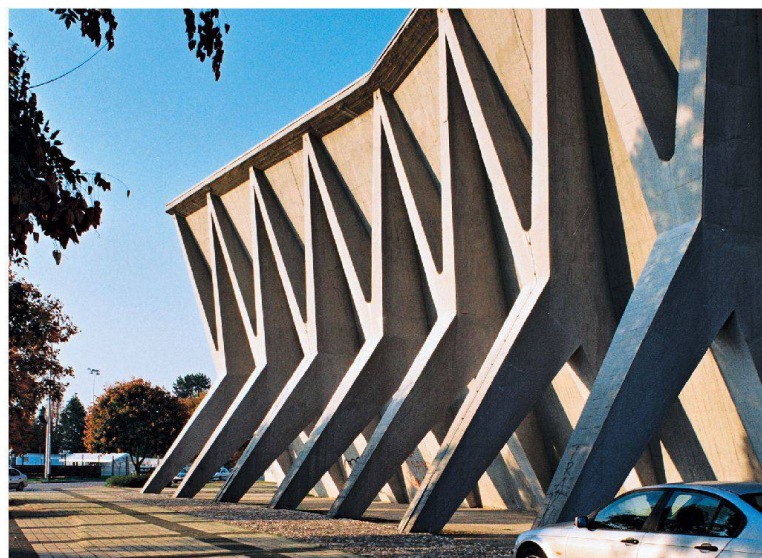
Pavillon der Zagreber Messe (1958) von Ivan Vitić: Kräftige Stützen halten das hängende Dach.
