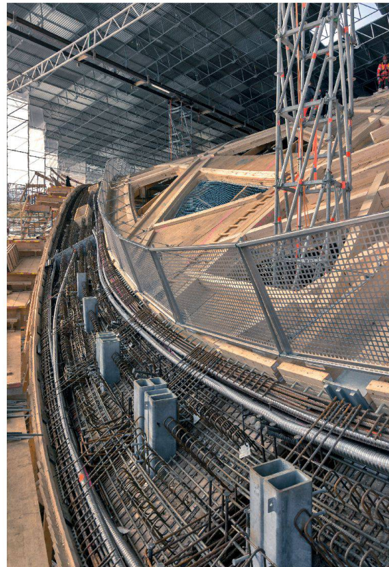
Ringbalken vor dem Betonieren mit den Stahleinbauteilen über den Betonstützen und den Hüllrohren für die Spannkabel.
