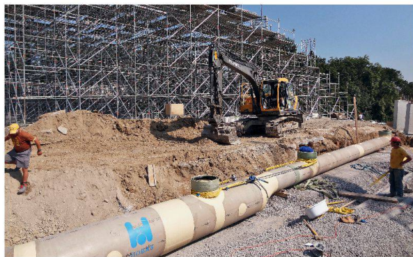
Verlegung der Lüftungsröhren von Hobas.
