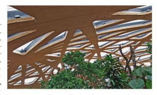
Der Ringbalken aus Beton mit Sika® ViscoCrete® Fliessmittel stützt das 1500 t schwere Holzdach.
