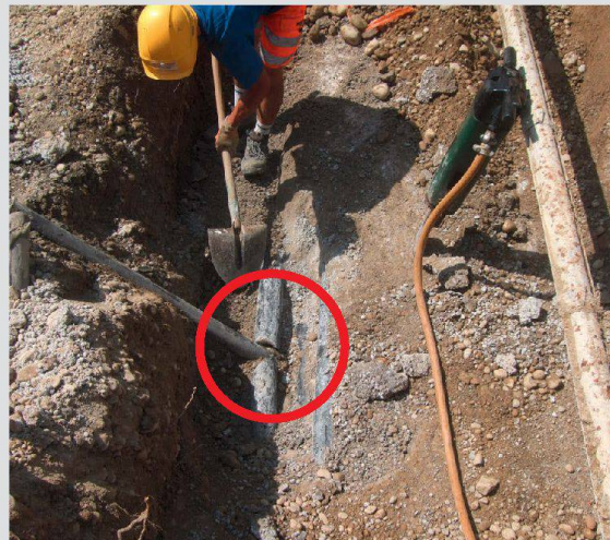
In Frauenfeld wurde bei Tiefbauarbeiten im August 2012 ein Rohrblock von Swisscom durchbohrt. Die Reparaturarbeiten dauerten mehr als fünf Tage.
