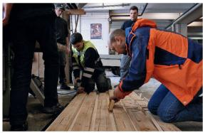
Die Schalung ist so konstruiert, dass das Feuer die Bretter in den Zwischenräumen nicht zu stark ausdünnt.
