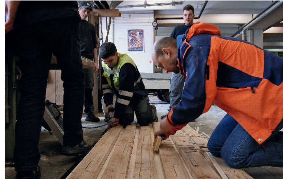
Die Schalung ist so konstruiert, dass das Feuer die Bretter in den Zwischenräumen nicht zu stark ausdünn.
