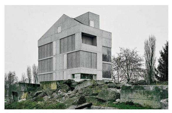
Die Fensterläden fügen sich diskret in die Fassade mit den Fertigbetonelementen und dem Ortbeton dazwischen. Einzig der Kontrollraum im Ergeschoss ist verglast.
