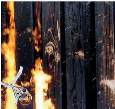
Drei Stufen: vom Flammen der Schalung über die verkohlte Oberfläche bis zum fertigen Element als Betonnegativ des Originals.
