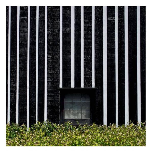
Normalerweise sind die Fassadenbretter kürzer als zwei Meter. Die Verwerfungen, die an den Kanten durch das Abflammen entstehen, sind in diesem Fall geringfügig. Bei den acht Meter langen Brettern des **Thermalbads** Lamune Onsen waren sie hingegen problematisch; daher wurden die Zwischenräume mit Mörtel ausgespachtelt.
