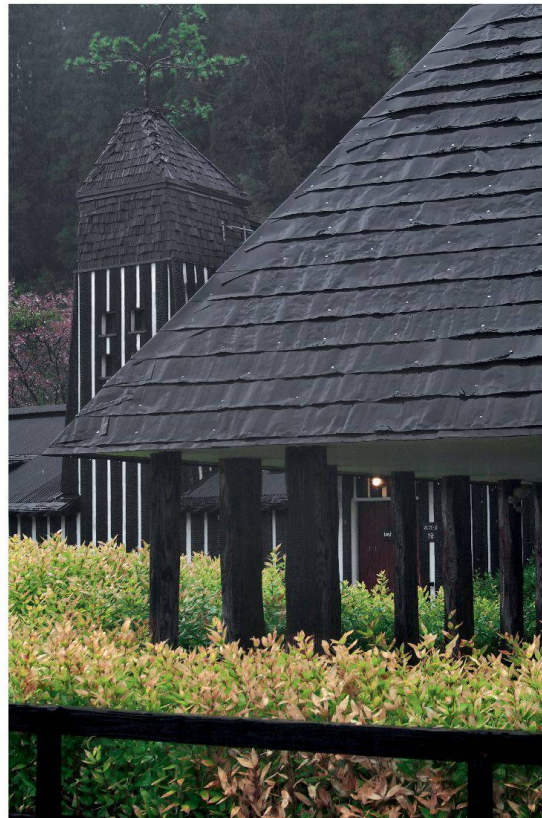
Die Kombination von angekohlten Zedernbrettern mit hellem Mörtel ergibt das charakteristische Zebramuster des Herrenbads.
