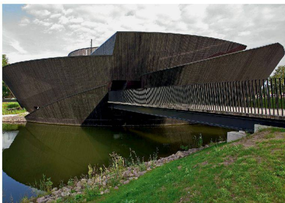
Einzelne Gebäudeteile des Natur-Erlebnis-Zentrum Müritzsee bei Warten stehen in einem Teich.
