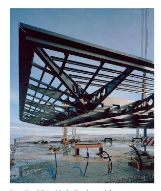
Ganz oben: 3-D-Ansicht der Unterkonstruktion Mitte und unten: Gesamtpavillon und Trägerrost während der Bauphase.
