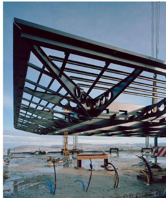
Ganz oben: 3-D-Ansicht der Unterkonstruktion Mitte und unten: Gesamtpavillon und Trägerrost während der Bauphase.
