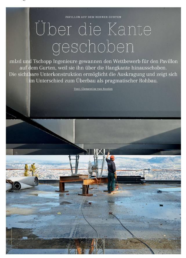
Der Trägerrost, der mit seinen verschliffenen Schweissnähten und seiner Scharfkantigkeit wie ein Möbel konstruiert ist: Ein Pneukran und drei Hilfsjoche inklusive Flaschenzüge zogen den Rost während der Bauphase in die definitive Höhenlage. Danach wurde er auf Stützen abgestellt, um als architektonisch prägende Dachtragkonstruktion zu funktionieren.
