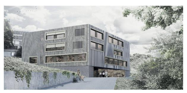
Das Siegerprojekt profitiert aufgrund seiner geringen Höhe von einem verkleinerten Grenzabstand. Die hinterlüftete Fassade aus stehenden Aluminiumprofilen fasst das Volumen einheitlich zusammen.
