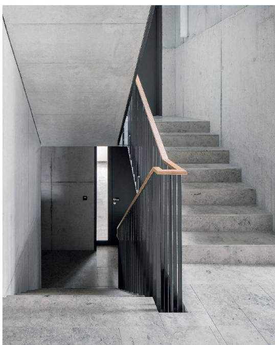
Vom Sechs- zum Dreispänner: Pro Halbgeschoss erschliesst ein Gang drei Wohnungen. Das erhöht die Privatheit. Dank Hanglage und Splitlevel-Lösung wurde zudem die Ausnützung optimiert.
