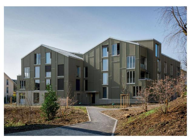
Satteldach, Gauben, Splitlevel, Vor- und Rücksprünge – dank einer Reihe von volumetrischen Kniffen fügt sich der Neubau in seine heterogene Umgebung ein. Die fein gegliederte Holzfassade verleiht ihm einen menschlichen Massstab.
