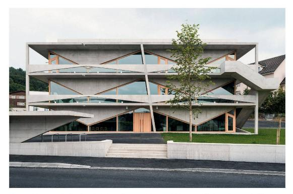
Die Fassade ist expressiv, ohne formalistisch zu sein: Der gezielte Materialeinsatz und die Gegensätze massiv-filigran ergeben sich aus den Kraftflüssen. Sämtliche Bauteile der äussersten Schicht des Gebäudes sind tragend ausgebildet.
