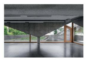
Die Decke braucht ein Linienauflager, doch für den Lastabtrag genügt eine Stütze – daraus entsteht die Dreieckwand.
