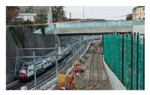
Auf dem neu gebauten Birchsteg werden die Lärmschutzwände aus Glas und Stahl der angrenzenden Stützmauern weitergeführt.
