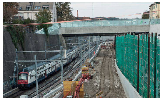
Auf dem neu gebauten Birchsteg werden die Lärmschutzwände aus Glas und Stahl der angrenzenden Stützmauern weitergeführt.
