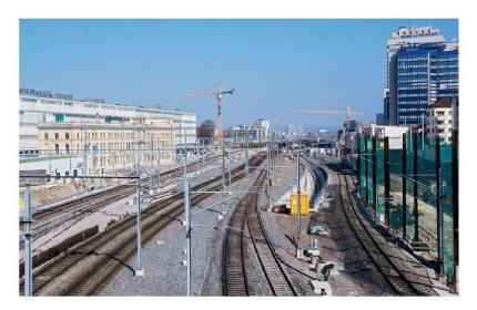
Im Gleisfeld, auf Höhe des Backsteingebäudes (ehemaliges Direktionsgebäude der MFO), ist die Ausfahrt des Unterquerungsbauwerks zu erkennen. Die SBB bauten dies, damit die Züge kreuzungsfrei verkehren können – so lässt sich die Kapazität steigern.
