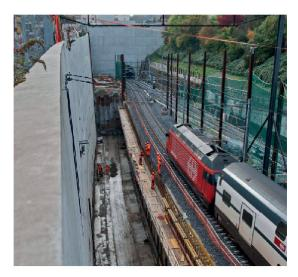
In der engen Baugrube zwischen Stützmauer und Gleis erstellten die Bauarbeiter bei laufendem Bahnbetrieb ein Tell des Portalbauwerks des Weinbergtunnels.
