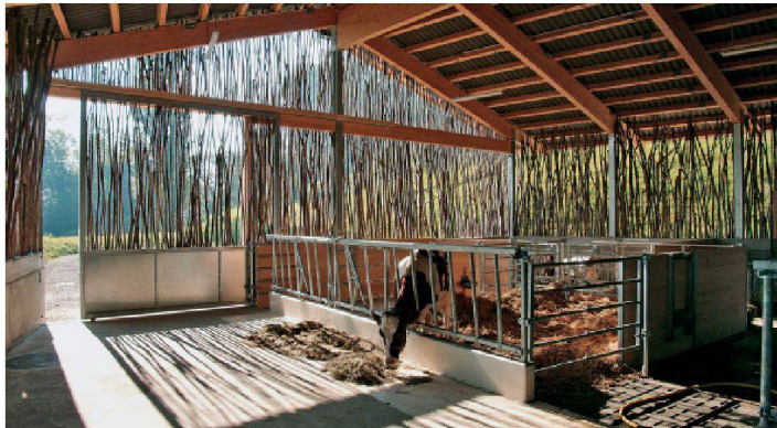
Kuhstall mit Wänden aus Haselruten – 2005 von F.A.B. Architekten in Schönberg bei Pratteln errichtet.
